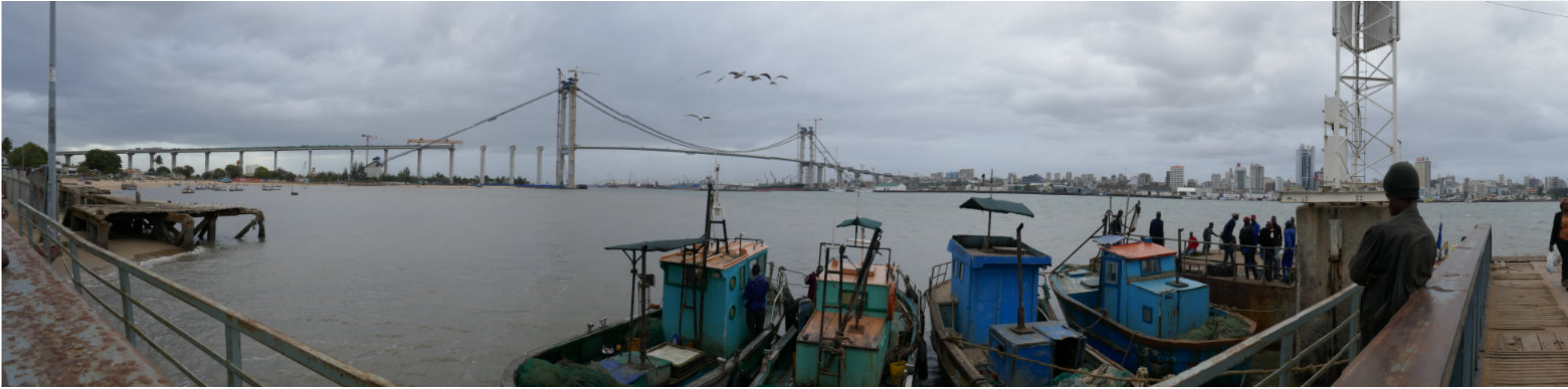
△ Vom Anlegesteg von Catembe aus haben wir bereits eine tolle Sicht auf die Brücke. Emmi, einer der Ingenieure, die wir auf dem Musikfestival in Malawi kennengelernt haben, wird uns hier abholen um uns anschließend die Brücken-Baustelle aus nächster Nähe zeigen.
